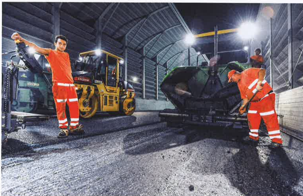
Bauarbeiter asphaltieren eine Autobahn bei Bissone TI. Nacht- und Schichtarbeit stellen ein hohes Risiko für einen gesunden Schlaf dar.
